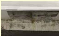
玄関昇降階段上の雨漏り箇所
